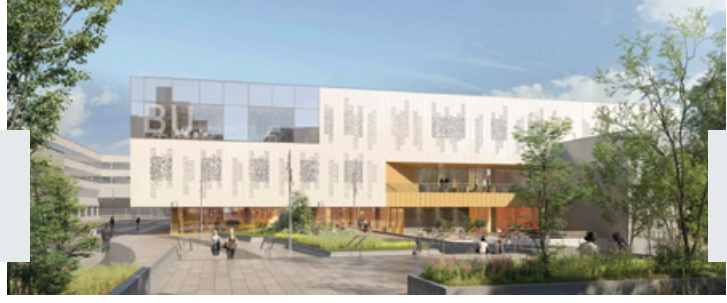
La future bibliothèque du Campus Pont-de-Bois
